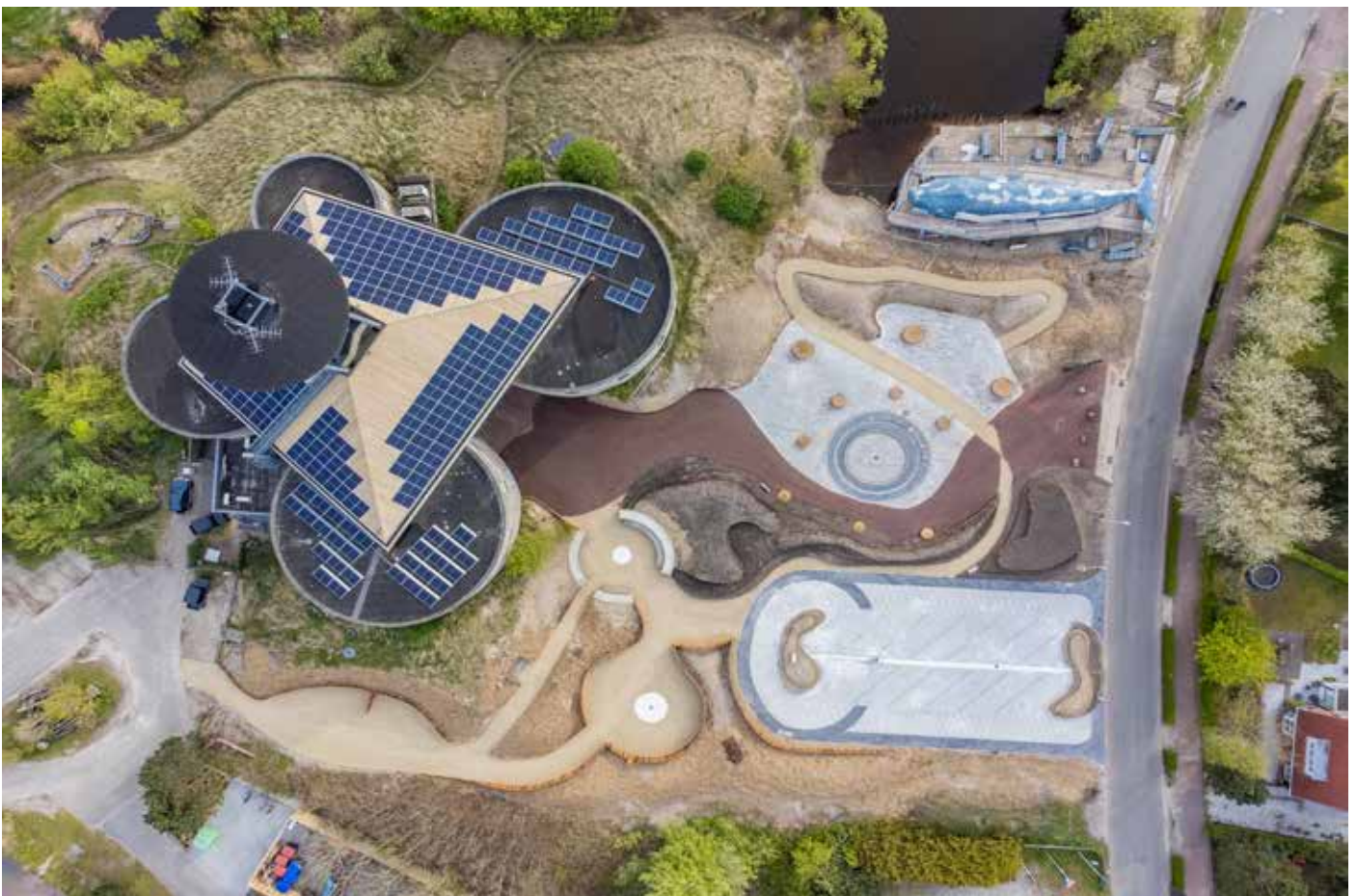
Nieuw buitenterrein Natuurcentrum, ten zuidwesten de locatie van de blauwe vinvis en zonnepanelen op het dak
